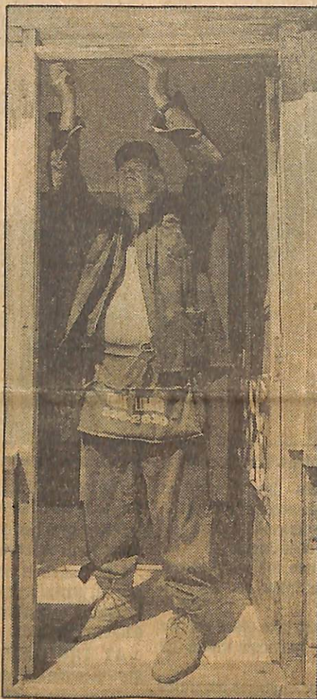
AL RIGG frames a new door project stage.
